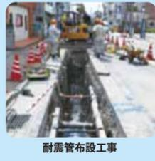
○災害時により迅速な応急給水を図るため、既設給水管に加え、新たに市立小中学校の水飲み場及び配水池・配水塔の給水栓までの耐震給水管を布設し、給水器具の設置等の手間が無く利用できる開設不要型応急給水拠点の整備を進めます。
