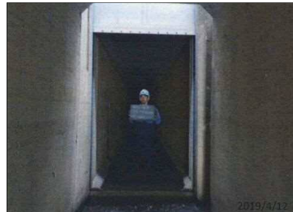
樋管ゲート写真
