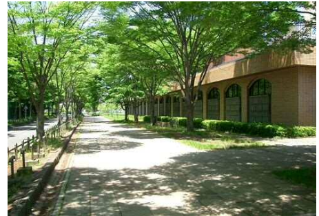
麻生水処理センター
