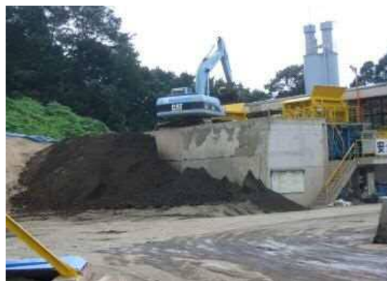
改良土プラント
