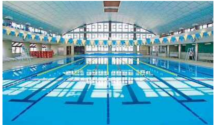
入江崎余熱利用プール
