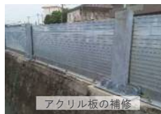
アクリル板の補修
