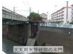
大丸用水接続部の水門
