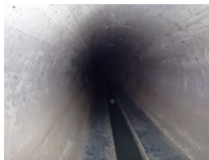
最下流部マンホールから上流
