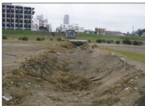
排水樋管周辺状況(台風後)
