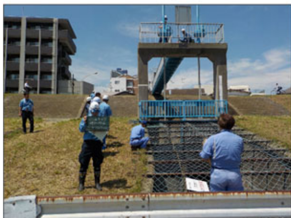
河川管理者による検査状況
