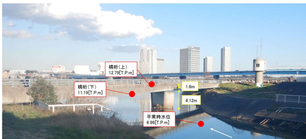
図 6-2-1 橋桁の高さ関係
