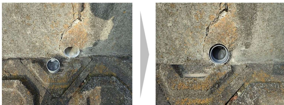
図 6-4-1 フラップゲート設置個所の状況
