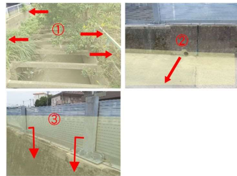
図 7-3-5 各浸水経路の状況
