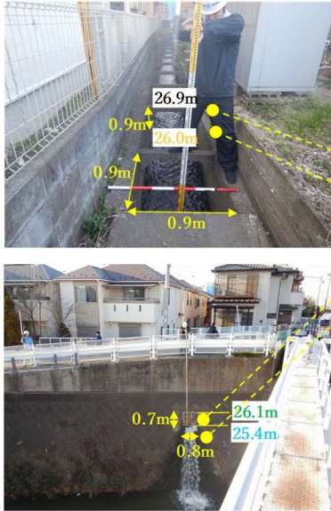
【吐き口部状況写真】
