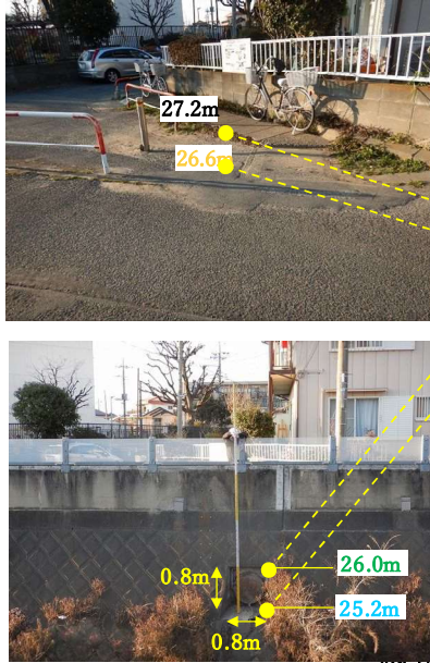
【吐き口部状況写真】
