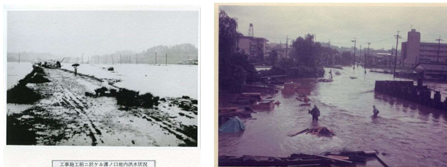
図 2-2-1 平瀬川の氾濫(左：高津区溝ノ口/昭和初期 右：高津区上作延/昭和51年)
