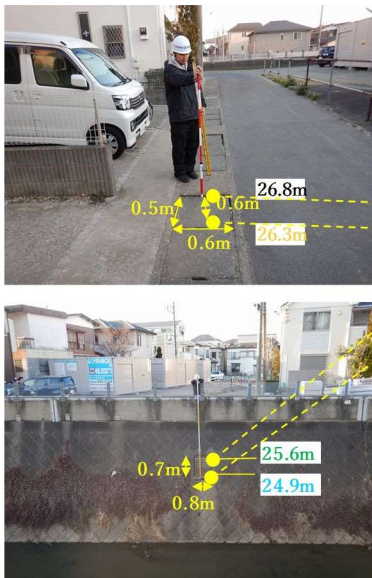
【吐き口部状況写真】
