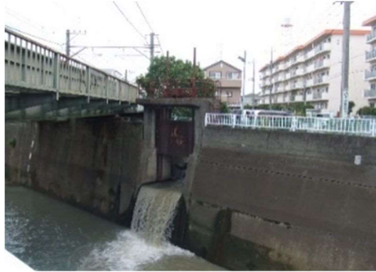
図 7-4-1 大丸用水接続部の水門
