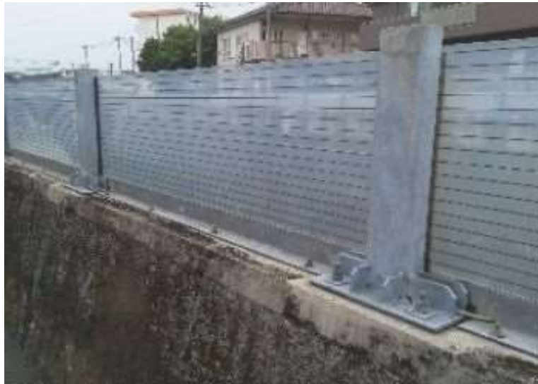
図 7-4-3 アクリル板の補修
