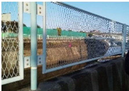
既存パラペット護岸
