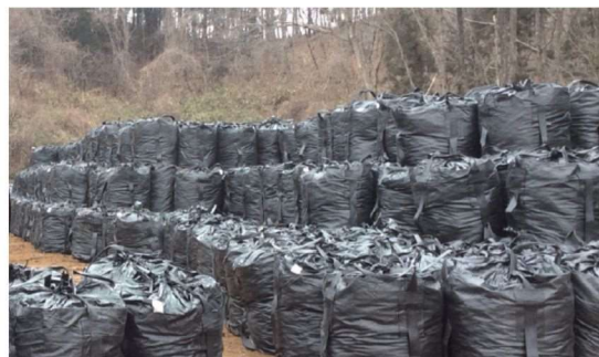
大型土のう（設置事例）
