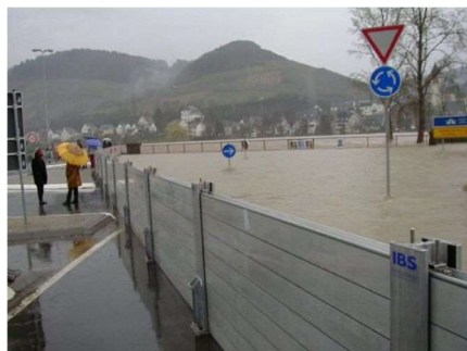
防水壁（設置事例）
