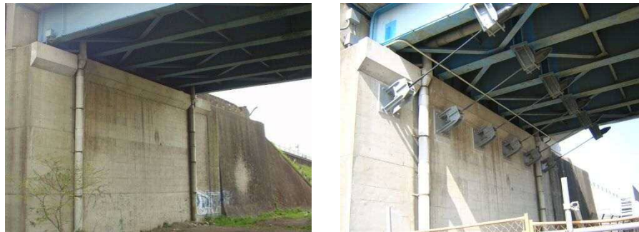
図 橋梁の耐震化工事（小倉跨線橋） (左：整備前、右：整備後)
