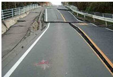
①寸断された道路 (水戸勝田那珂湊線)
