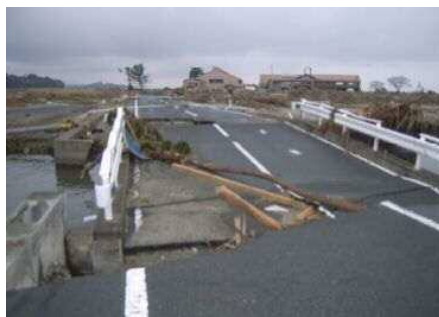
②落下した橋梁 (宮城県山元町 相馬亘理線)
