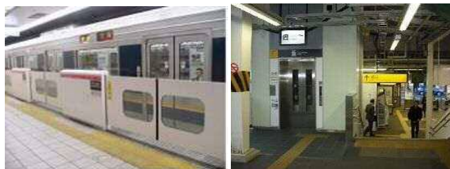
①可動式ホーム柵 ②エレベーター
