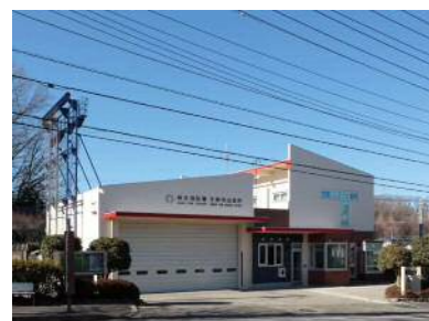
麻生消防署王禅寺出張所
