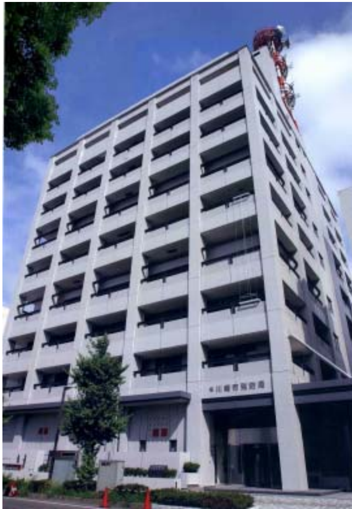
消防局総合庁舎
