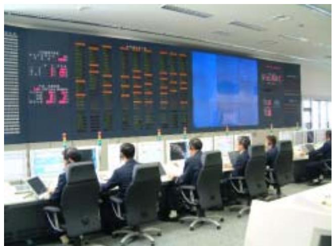
消防指令システム
