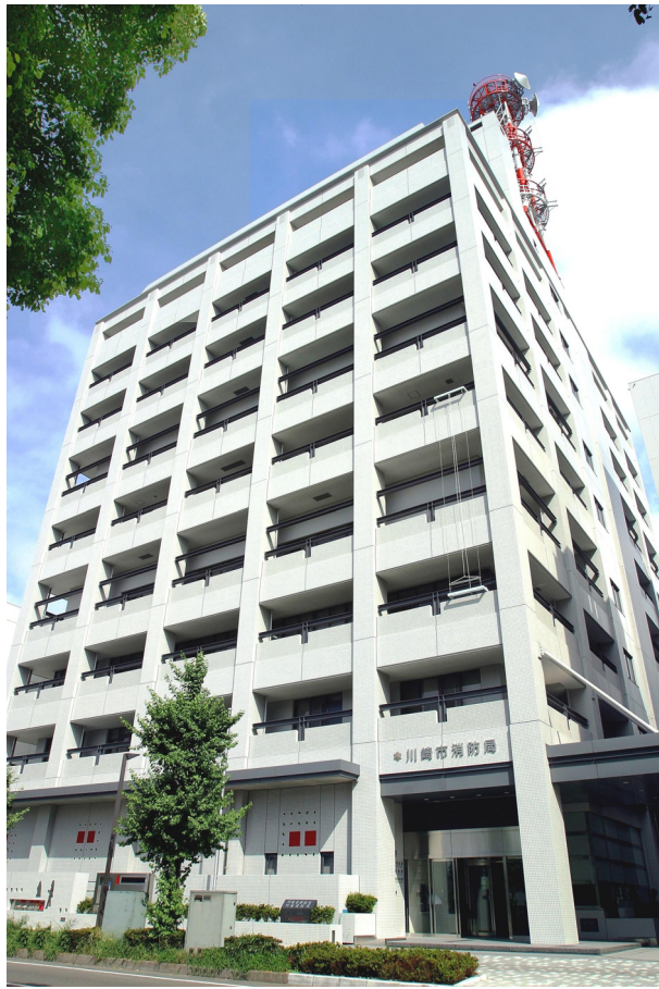
川崎市消防局総合庁舎
