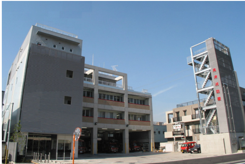
高津消防署新庁舎
