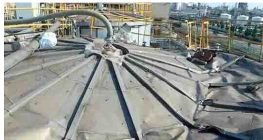
図 2 写真（事故後のタンク頂部）
