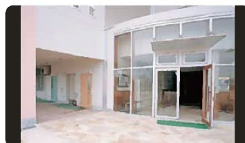
外部からも使用できるトイレ（神戸市立池田小学校）
