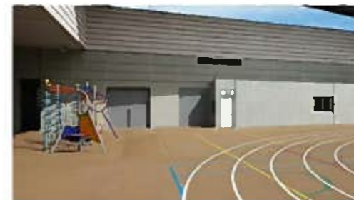
屋上グラウンド（中央区立中央小学校）
