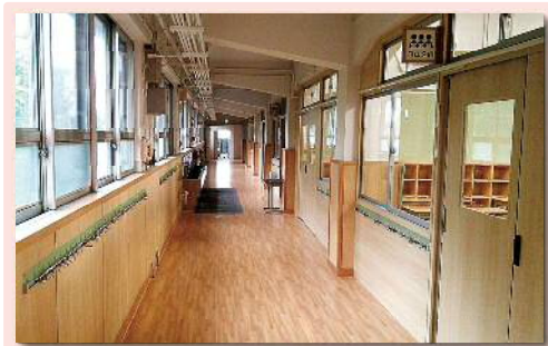
再生整備による内装改修
