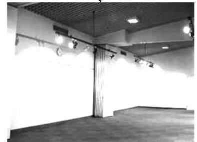
イベントホールA～Cは可動式のパーティションで仕切られ、一体的な利用も可能
