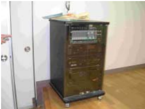
( L小、Q中で施設扱いとなっているワゴンアンプ )
