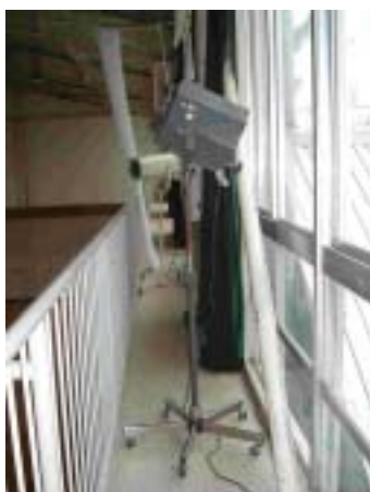
(手前のスポットライト 施設として管理、奥のスポットライト 備品として管理)
