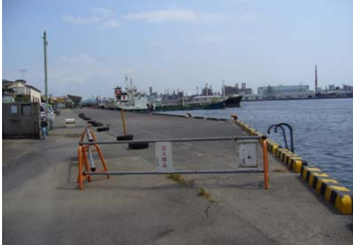
(写真) 陸上から撮影した夜光物揚場
