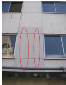
（写真 2）耐震スリット新設工事（丸囲箇所）
