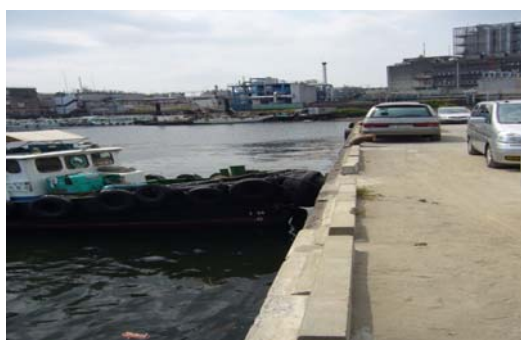
(写真) 陸上から撮影した小島新田物揚場
