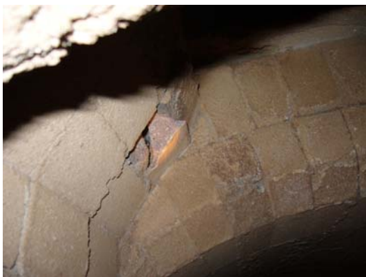
(写真) レンガがヒビ割れた炉内
