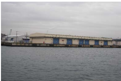
(写真) 海上から撮影した千鳥町1号係船岸壁
