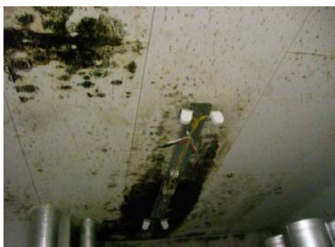
(写真) 倉庫の天井のカビ、染み
