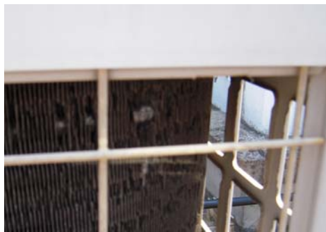
(写真) 腐食した空調設備 2
