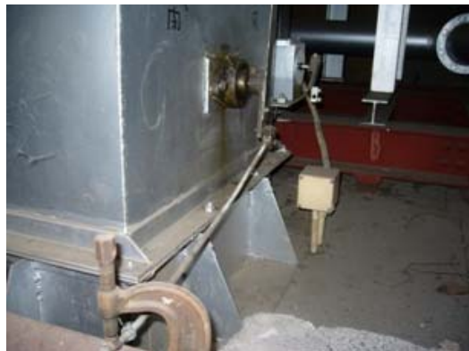
(写真) 半開きに固定したダンパー
