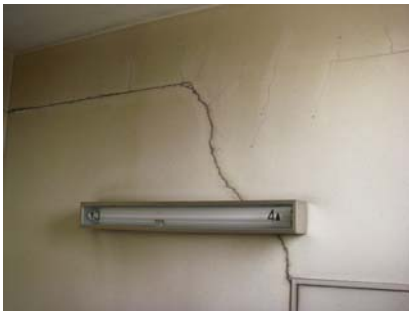
(写真) 壁の亀裂
