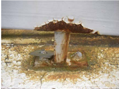
(写真) 腐食したボルト
