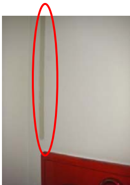
（写真）耐震スリット新設工事（丸囲箇所）
