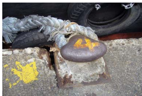
(写真) 鉄筋が露出していることから腐食が進んでいると思われる。
