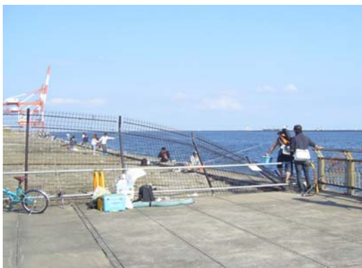
(写真) 台風で倒壊したフェンス
