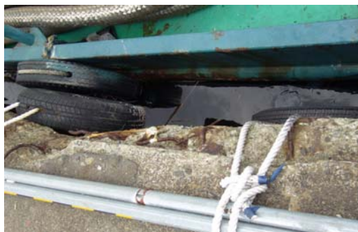
(写真) 鉄筋が露出していることから腐食が進んでいると思われる。
