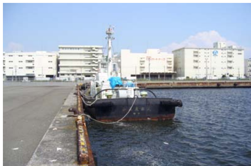
(写真) 陸上から撮影した東扇島 ABCD 号岸壁
