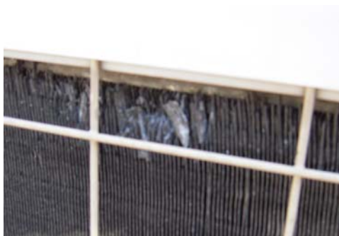
(写真) 腐食した空調設備 1
