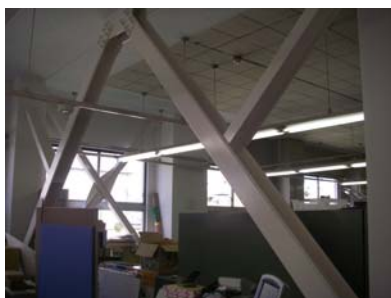
（写真 1）鉄骨ブレース設置工事
