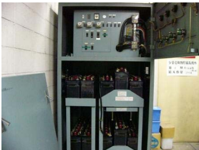
(写真) 緊急用バッテリー装置
