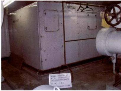
(写真) 空気調和設備修繕前
