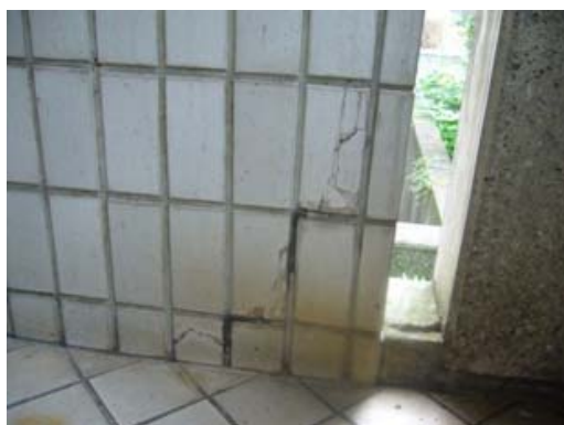
(写真) 火葬棟外壁タイルの亀裂
