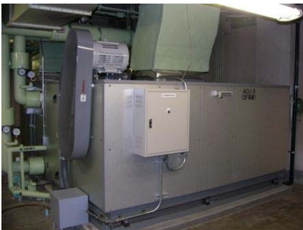
(写真) 空気調和設備修繕後
