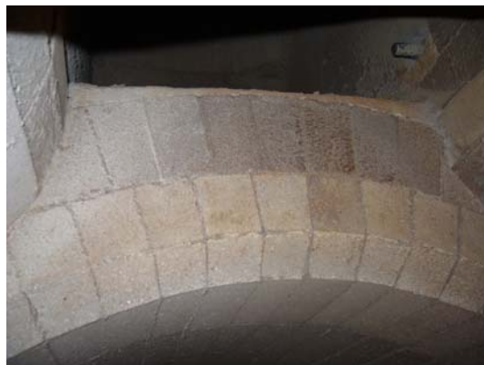
(写真) 補修された炉内
