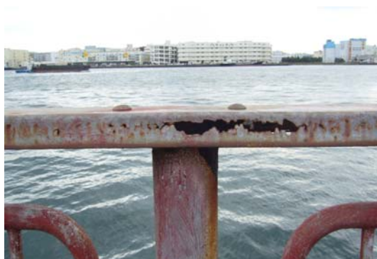
(写真) 錆を原因として穴があいている
