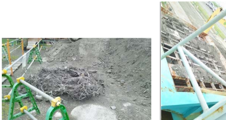
事前除去された金属類（左）と焼却灰投入ホッパの状況（右） （平成24年7月6日 浮島埋立事業所のFCS設備の前）
