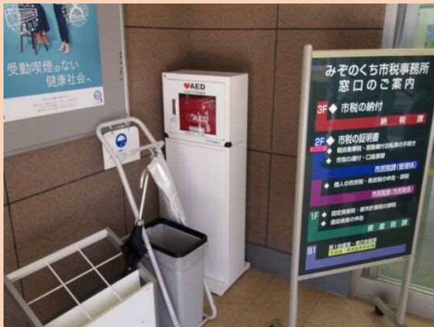
図 33 設置場所周辺に物が置かれアクセスしにくくなっていた事例（みそのくち市税事務所）
