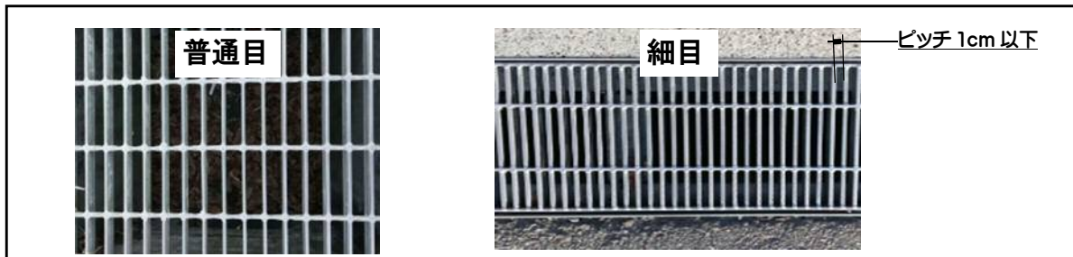
図 9 グレーチングの目
