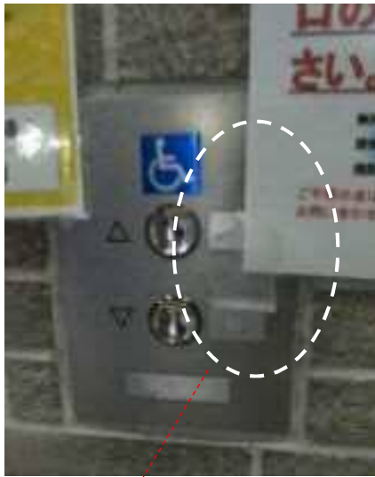
図 26 押ボタンの点字表示が機能していなかった事例(多摩区役所)
