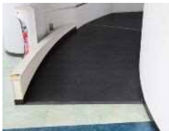
図 19 建物内の傾斜路・階段に手すりがない(港湾振興会館(川崎マリエン))
