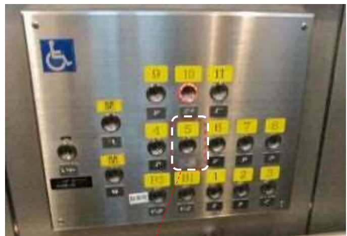
図 26 押ボタンの点字表示が機能していなかった事例(多摩区役所)
