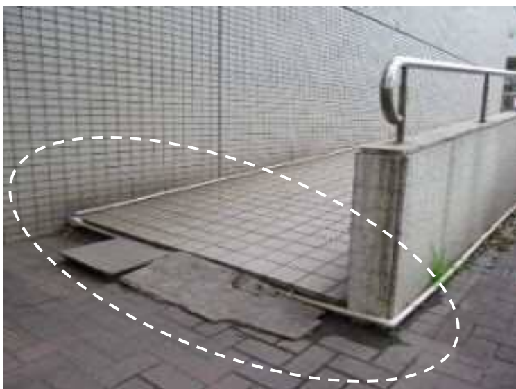
図 25 傾斜路の下端に 2 cm を超える段差がある
