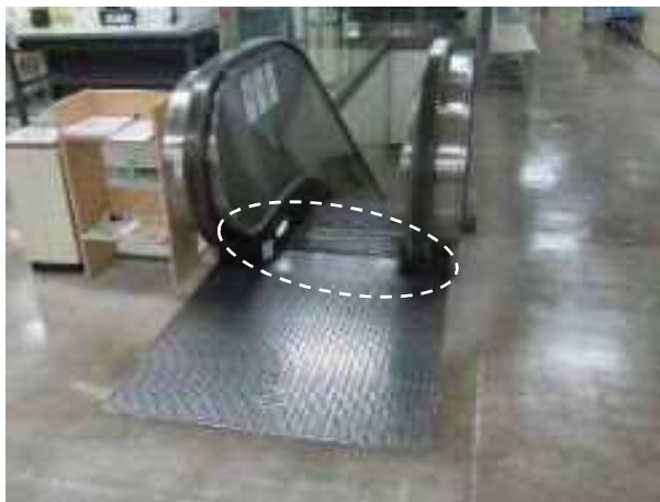
(a)川崎区役所
