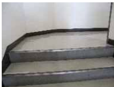
(h)川崎区役所田島支所
