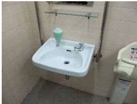
図 67 多機能トイレの手洗い場の水栓がレバー式又は自動式ではない(川崎区役所大師支所)
