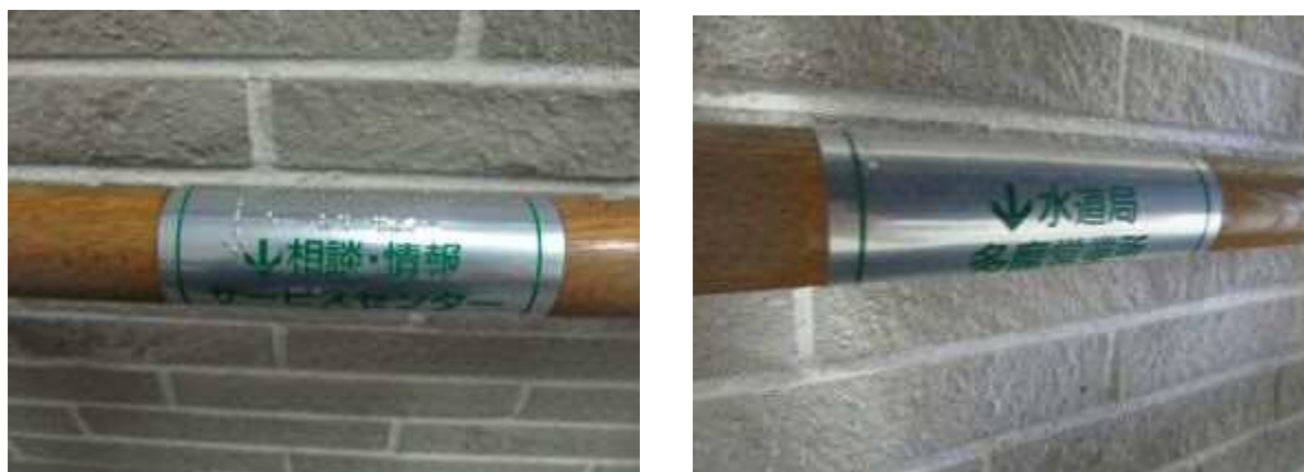
図 54 手すりに以前あった部署の名称を点字及び日本語で表示（多摩区役所）
