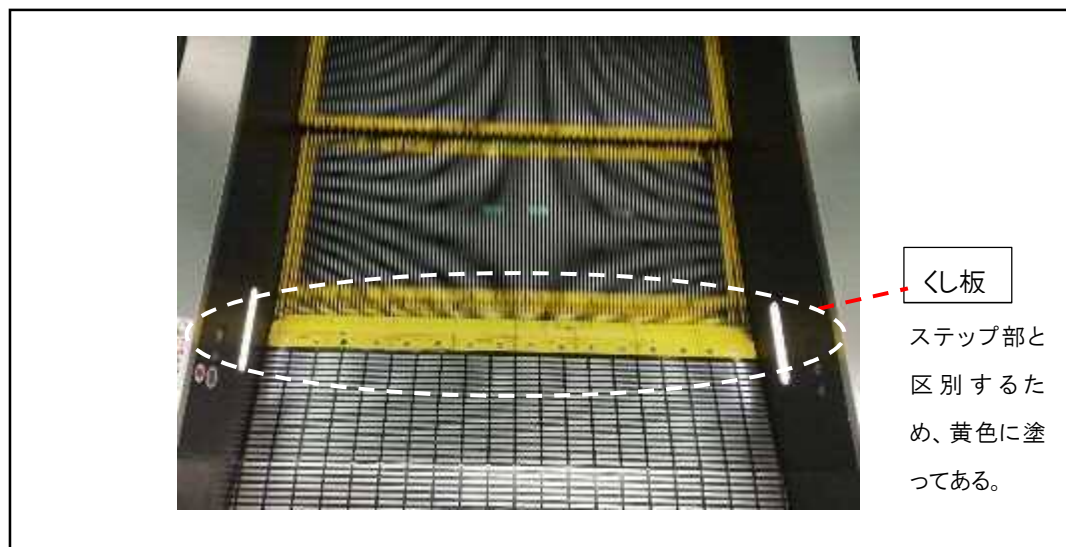
図 27 エスカレーターのくし板の色
