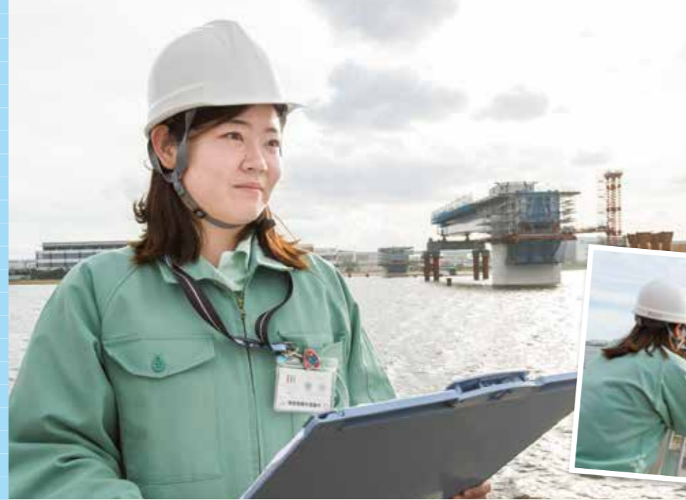
羽田連絡道路工事現場
