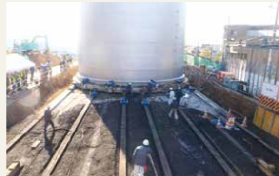
宮崎配水塔更新工事現場
