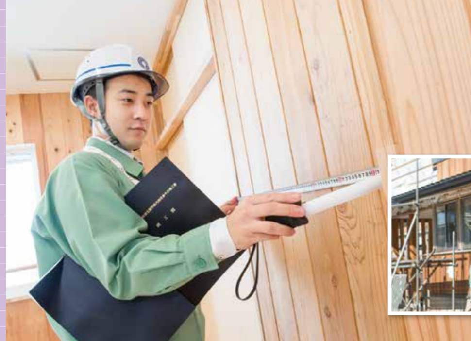
生田保育園工事現場 (国産木材の利用)
