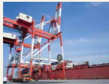
川崎港コンテナターミナル(ガントリークレーン)
