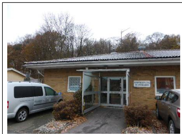
エルドラド知的障害者対象センターの正面玄関
