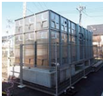
新たに設置されたステンレス製の受水槽
