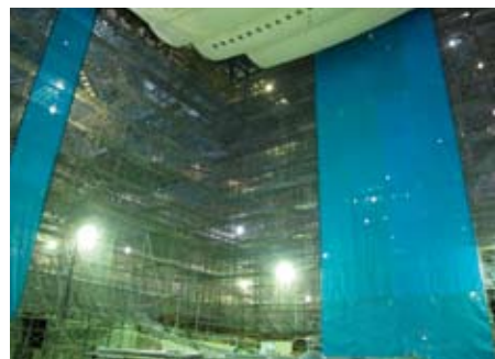
復旧工事中のシンフォニーホールの内部
