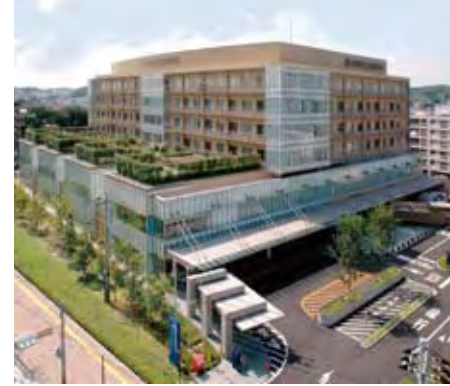
市立多摩病院の外観
