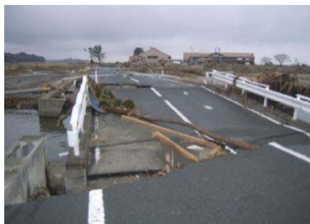
②落下した橋梁 (宮城県山元町 相馬亘理線)
