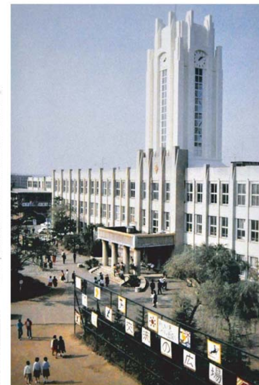
1985年のリニューアル 工事前の写真
