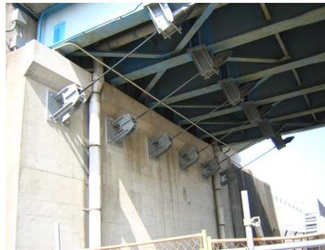
図 橋梁の耐震化工事（小倉跨線橋）
