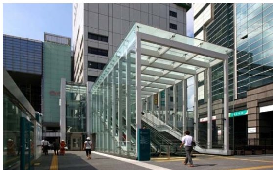
写真 川崎駅東西連絡歩道橋のバリアフリー整備 （出典）川崎市HP
