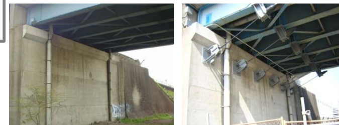
写真 橋梁の耐震化工事（再掲）（小倉跨線橋）（左：整備前、右：整備後） （出典）川崎市資料
