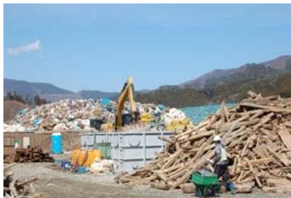
柱材の塩分を重機を用いて水洗いする様子
