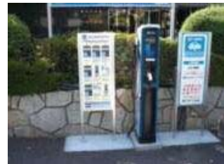
燃料電池システム (燃料電池と蓄電池とのハイブリッド)
