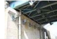
橋梁の耐震化 (市内整備事例)
