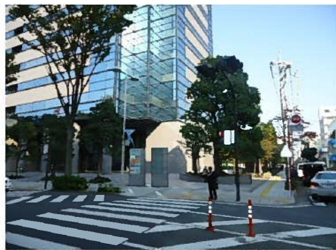
タワープレイス南東角の状況
