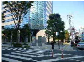
タワープレイス南東角の状況
