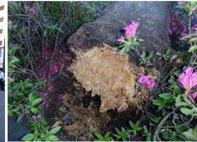
図2 倒木した根元の腐朽状況
