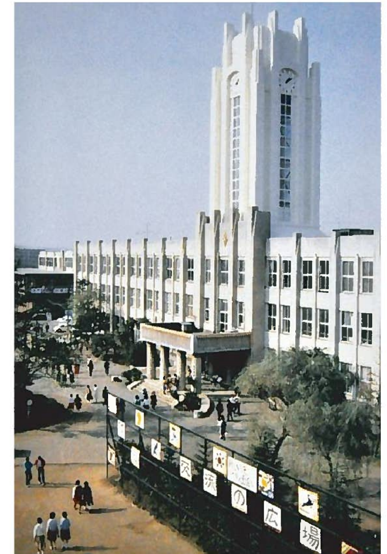
1985年のリニューアル 工事前の写真
