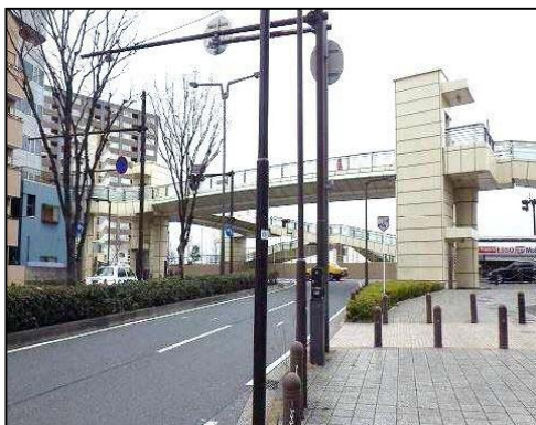
図 5-6 さいわい歩道橋
