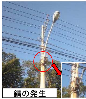
図 3-12 照明柱の劣化状況
