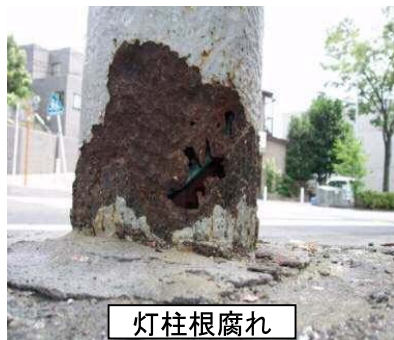
図 3-12 照明柱の劣化状況
