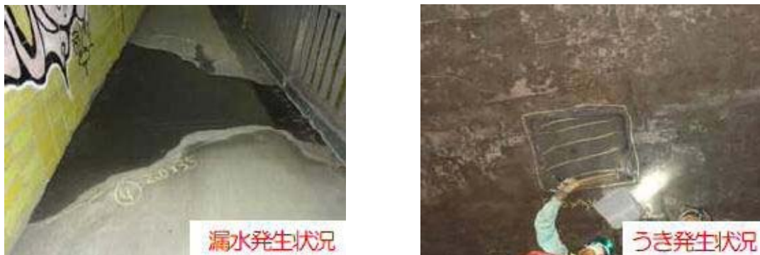
図 3-8 劣化の事例（末長トンネル）
