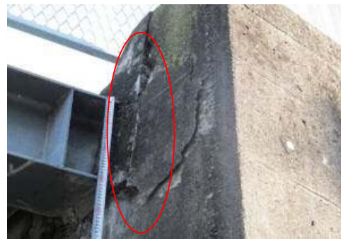
コンクリートの剥離
