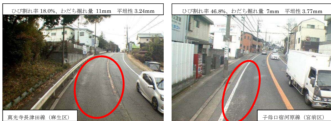
図 3-3 舗装の劣化状況
