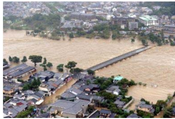
平成25年9月台風15号 京都市内 桂川の氾濫
