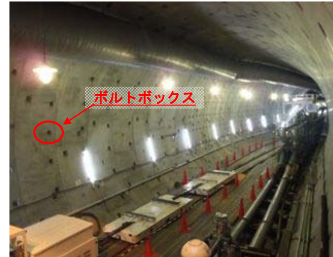
トンネル部内部の写真
