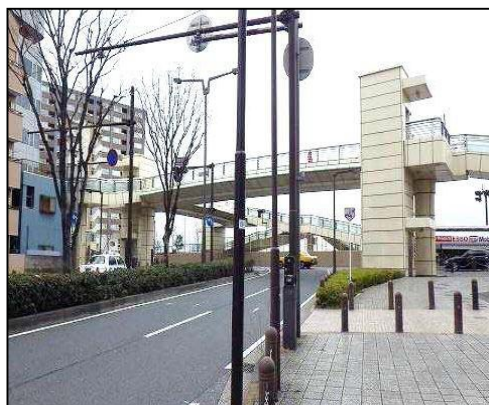
図 5-6 さいわい歩道橋
