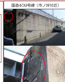
コンクリートの剥離
