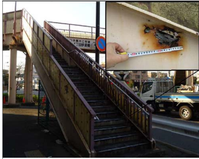
図 3-1 1 横断歩道橋 損傷状況写真
