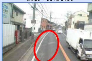
子母口宿河原線(宮前区) ひび割れ率46.8%、わだち掘れ量7mm、平坦性3.77mm
