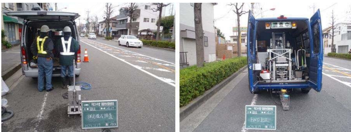
図 5-3 舗装下の詳細調査状況（FWD調査）
