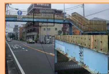
横断歩道橋の劣化状況
