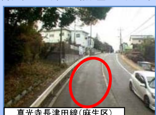
真光寺長津田線(麻生区) ひび割れ率18.0%、わだち掘れ量11mm、平坦性3.24mm
