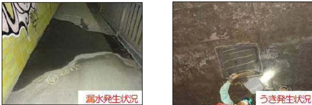
図 3-8 劣化の事例（末長トンネル）
