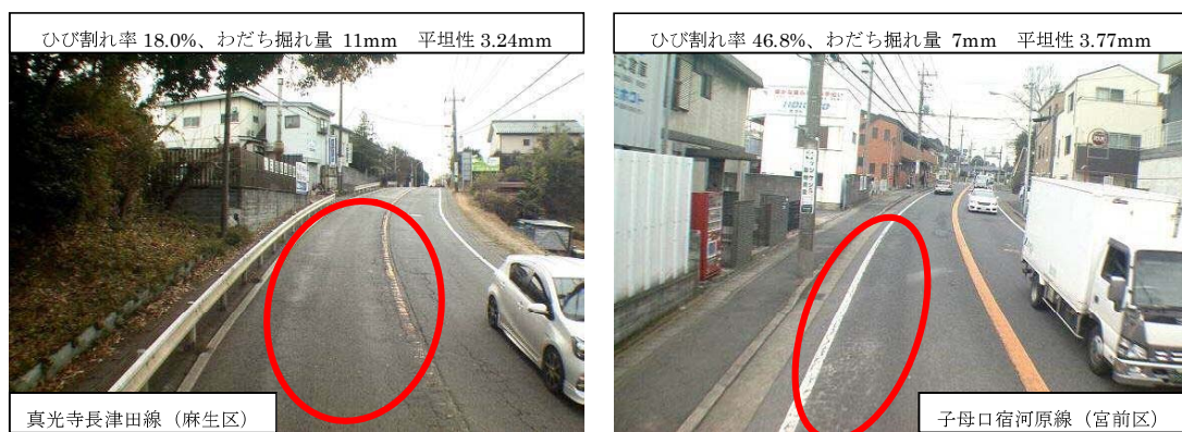
図 3-3 舗装の劣化状況
