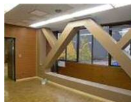
特定建築物 鉄骨ブレース施工
