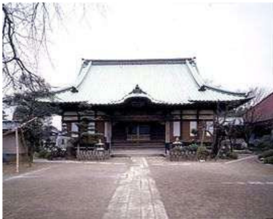
長念寺本堂（建造物 多摩区）
