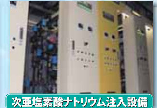
次亜塩素酸ナトリウム注入設備
