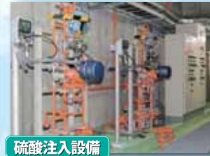
硫酸注入設備
