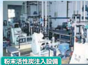
粉末活性炭注入設備
