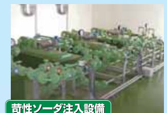
苛性ソーダ注入設備
