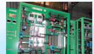
ポリ塩化アルミニウム注入設備
