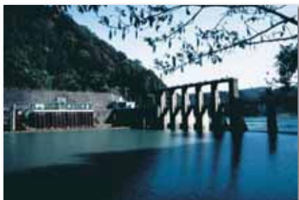
● 沼本ダム原水取水口 (標高121m)
