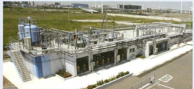
施設全景(その2工事)
