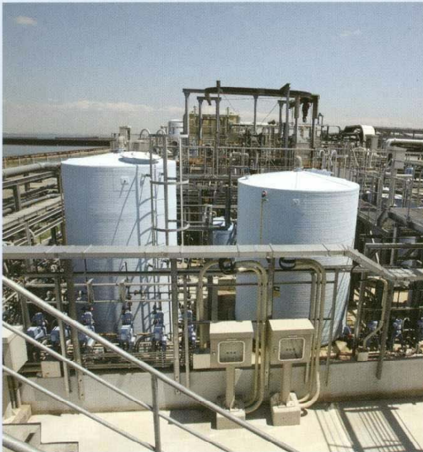
施設全景(その1工事)
