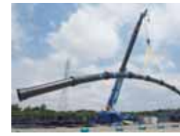
吊り上げても抜けない耐震管
