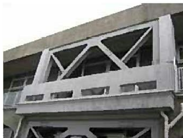
建築構造物（管理棟）の耐震化（ブレースの設置）
