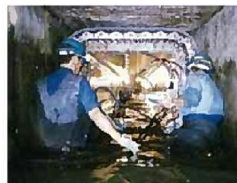
更生工法による 老朽化管きよの再整備状況
