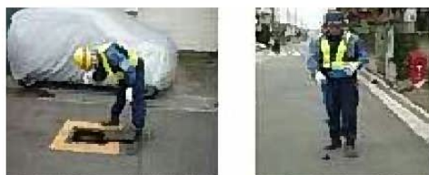
漏水調査の様子
