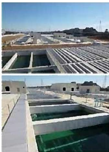
ろ過池・配水池等更新工事
