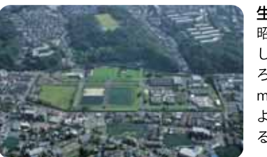
生田浄水場 昭和13年5月に通水を開始しました。処理方法は急速ろ過方式、施設能力は10万m 3 /日です。再構築計画により平成27年度末に廃止する予定です。
