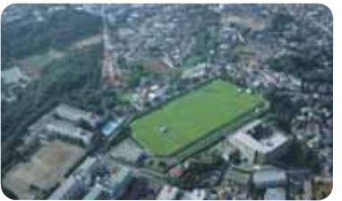
末吉配水池 昭和30年10月に完成した有効容量約7.2万m 3 の横浜市鶴見区に所在する配水池です。
