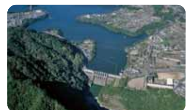
城山ダム 昭和40年に完成しました。神奈川県、横浜市、川崎市、横須賀市の共同事業である相模川総合開発事業として発電、水道用水、工業用水などを目的として建設されました。
