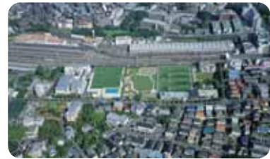
鷺沼配水池 昭和42年10月に完成した有効容量約11.2万m 3 の本市最大の配水池です。また上部を広場、フットサルコート、小学校校庭として利用しています。
