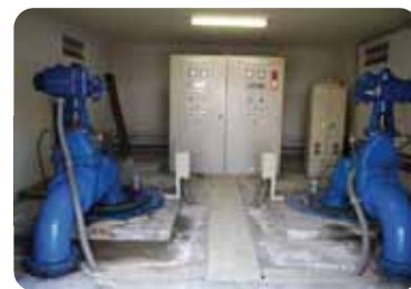
生田さく井 市内多摩区のさく井(浅井戸)6か所から地下水を汲み上げています。
