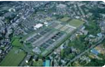
潮見台配水池 再構築計画により平成23年度末に浄水場としての機能を廃止し、配水施設(配水池・送水ポンプなど)となりました。配水池は、昭和46年3月完成、有効容量約2.8万m 3 。
