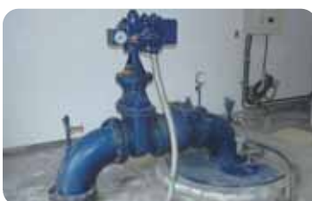
生田さく井 市内多摩区のさく井(浅井戸)6か所から地下水を汲み上げています。
