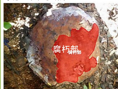
図6 切断面の腐朽状況(腐朽率37%)
