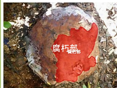
図6 切断面の腐朽状況 (腐朽率37%)
